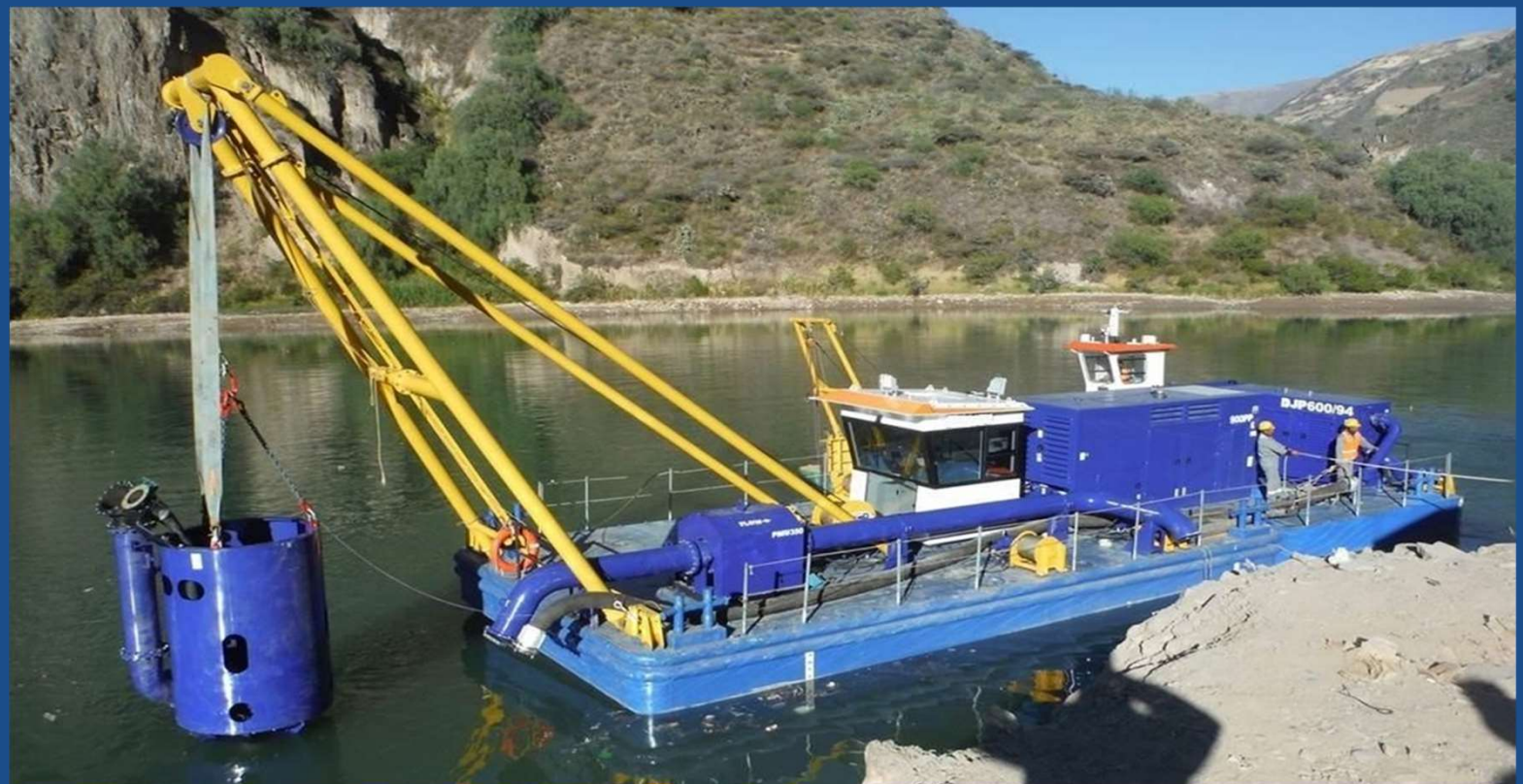
Dragagem com bomba DOP içada por guincho
